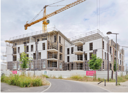
Chantier en cours. ■ 2024 ■ ©Olivier Frajman
