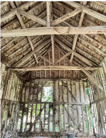
Documentation détaillée de l'état de la grange. Numérotation des pièces en bois et tri des matériaux récupérables. Démontage soigné des éléments structurels. ■ 2023 ■ ©Cinq-Cinq
