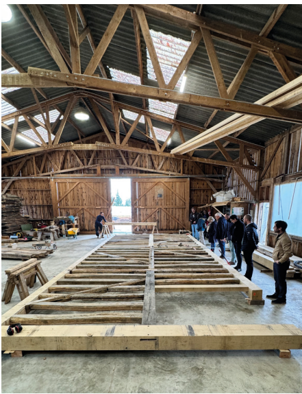
Réassemblage de la structure en pans de bois. ■ 2024 ■ ©Cinq-Cinq
