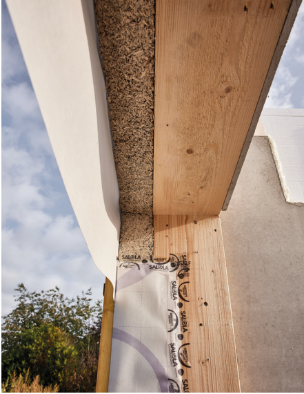
Façades ossature bois préfabriquées localement, remplissage de béton de chanvre. ■ 2024 ■ ©Olivier Frajman
