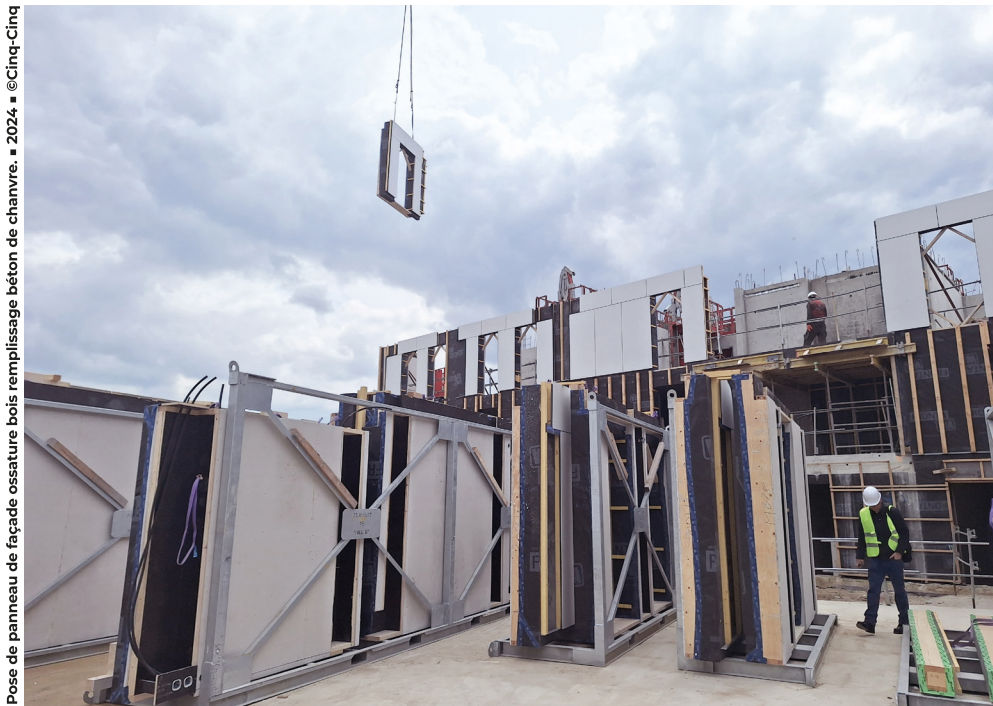
Façades ossature bois préfabriquées localement, remplissage de béton de chanvre. ■ 2024 ■ ©Olivier Frajman
