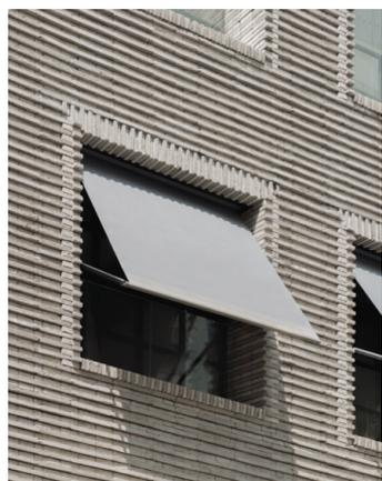
Brique porteuse, châssis acier, store textile • 2023 • ©Nicolas Trouillard
