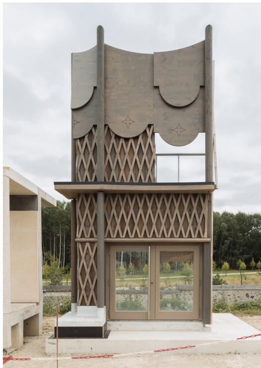
Prototypage de façade, treilles, panneaux 5 piliers, ossature bois • 2024 • ©Nicolas Trouillard
