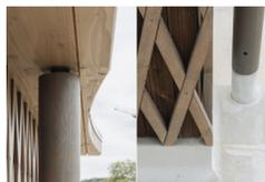
Prototypage raccord poteau bois avec corniche bois et son seuil formant assise en béton préfabriqué • 2024 • ©Nicolas Trouillard
