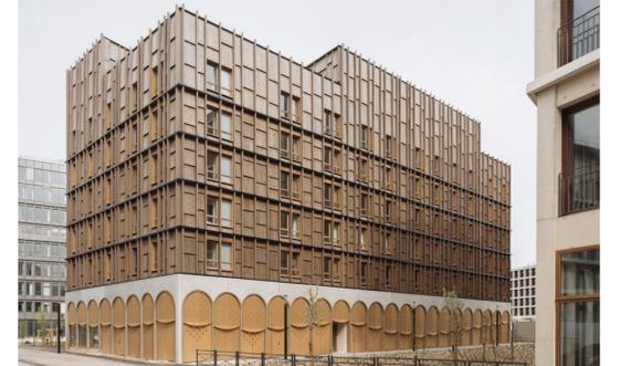
Sur un socle d'arches béton et de lambrequins métalliques, s'empilent les strates en écaïles de bois • 2024 • ©Nicolas Trouillard
