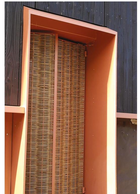
Cadre d'une baie au RDC avec persiennes en tréssage d'osier pour la protection solaire et la V.N jour et nuit • 2024 • ©ABF-LAB
