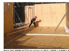
Pose des MOB et CLT en cours au R+1 • 2023 • ©ABF-LAB
