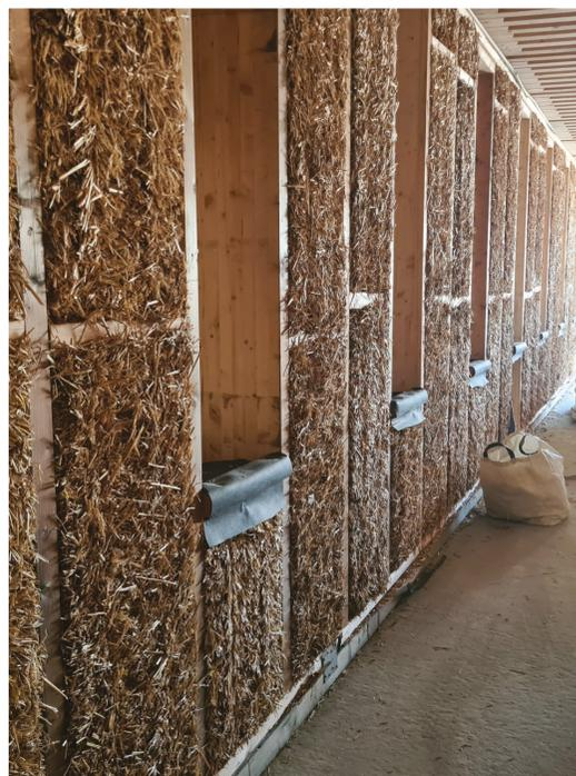
Mur à Ossature bois (MOB) avec remplissage de bottes de paille, mur perspirant • 2024 • ©ABF-LAB
