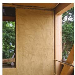
Enduit de terre argileuse locale sur l'ensemble des parois intérieures des MOB façade • 2024 • ©ABF-LAB
