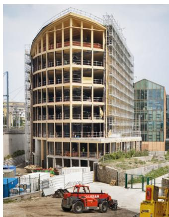
Siège de l'Urssaf - Structure poteau poutre lamellé collé • 2019 • ©Takuji Shimmura
