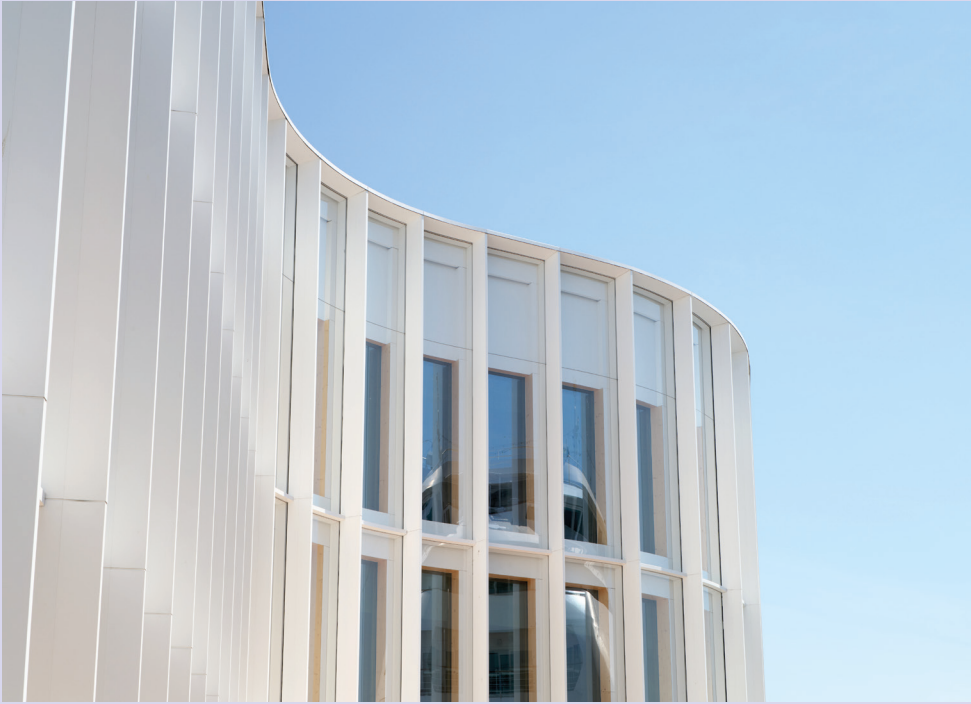
Facade incurvée Katajanokan Laituri • 2024 • ©Tuomas Uusheimo
