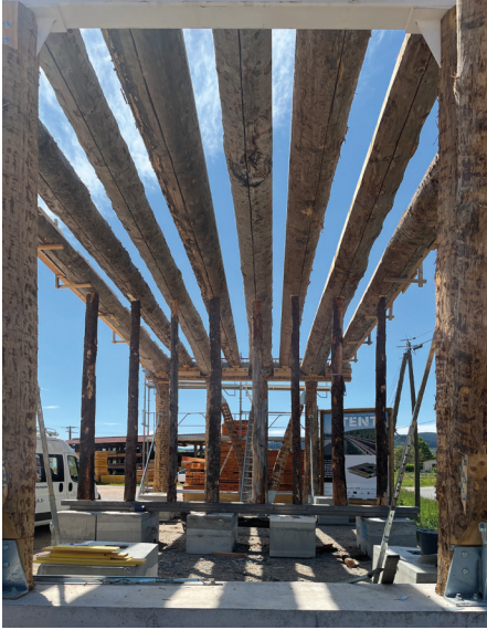
Montage du prototype grandeur réelle • 2023 • ©ARCHIPENTE
