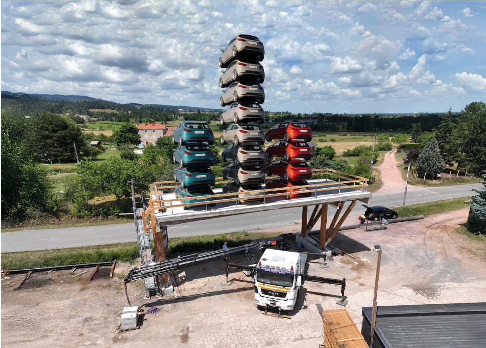
Essais grandeur réelle : 30tonnes : 9mm de fêche • 2023 • ©ARCHIPENTE
