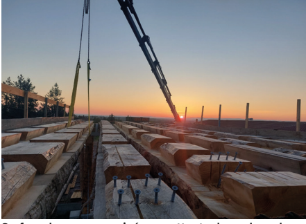
Surface des grumes usinées en attente du coulage du béton • 2023 • ©ARCHIPENTE
