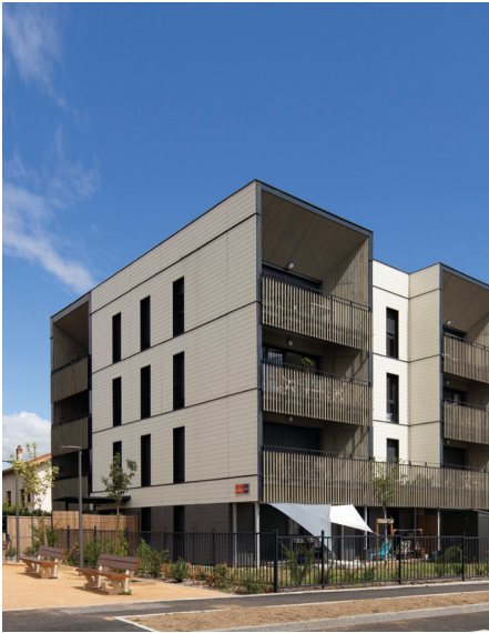
Bâtiment collectif en retrait pour générer un nouvel espace public • 2022 • ©Pauline Chovet
