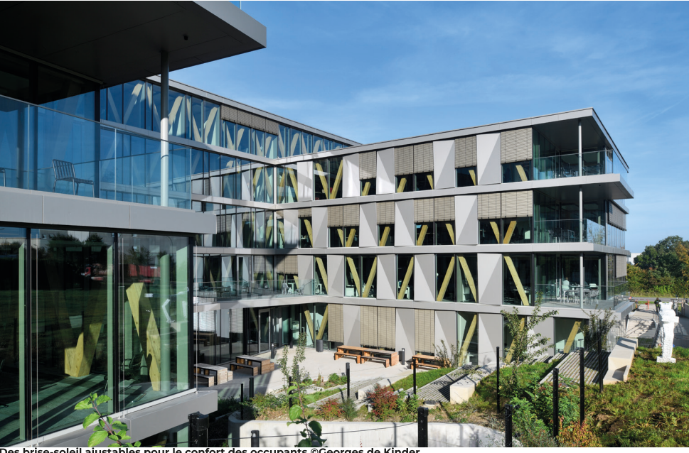
Des brise-soleil ajustables pour le confort des occupants ©Georges de Kinder
