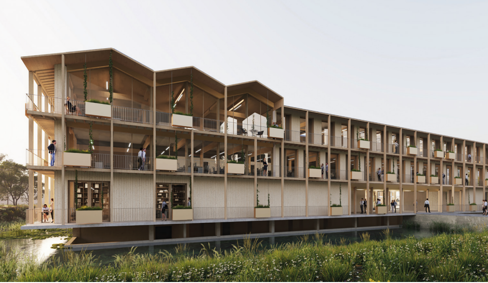
Vue mettant en avant le côté préfabriqué et modulaire de la façade en bois ©ArtBuild
