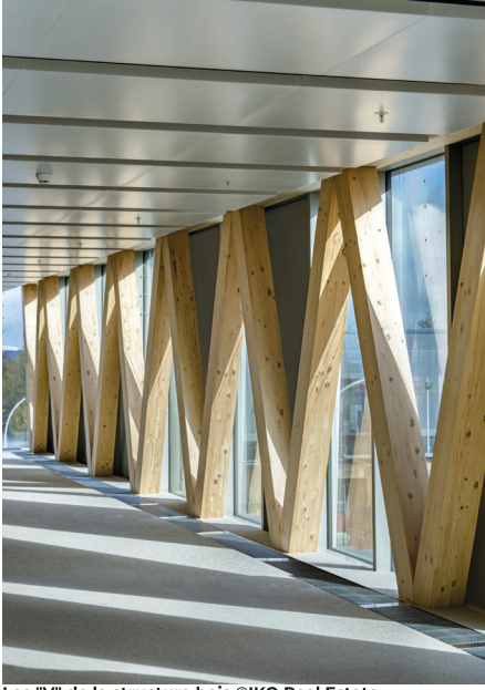
Les "V" de la structure bois ©IKO Real Estate
