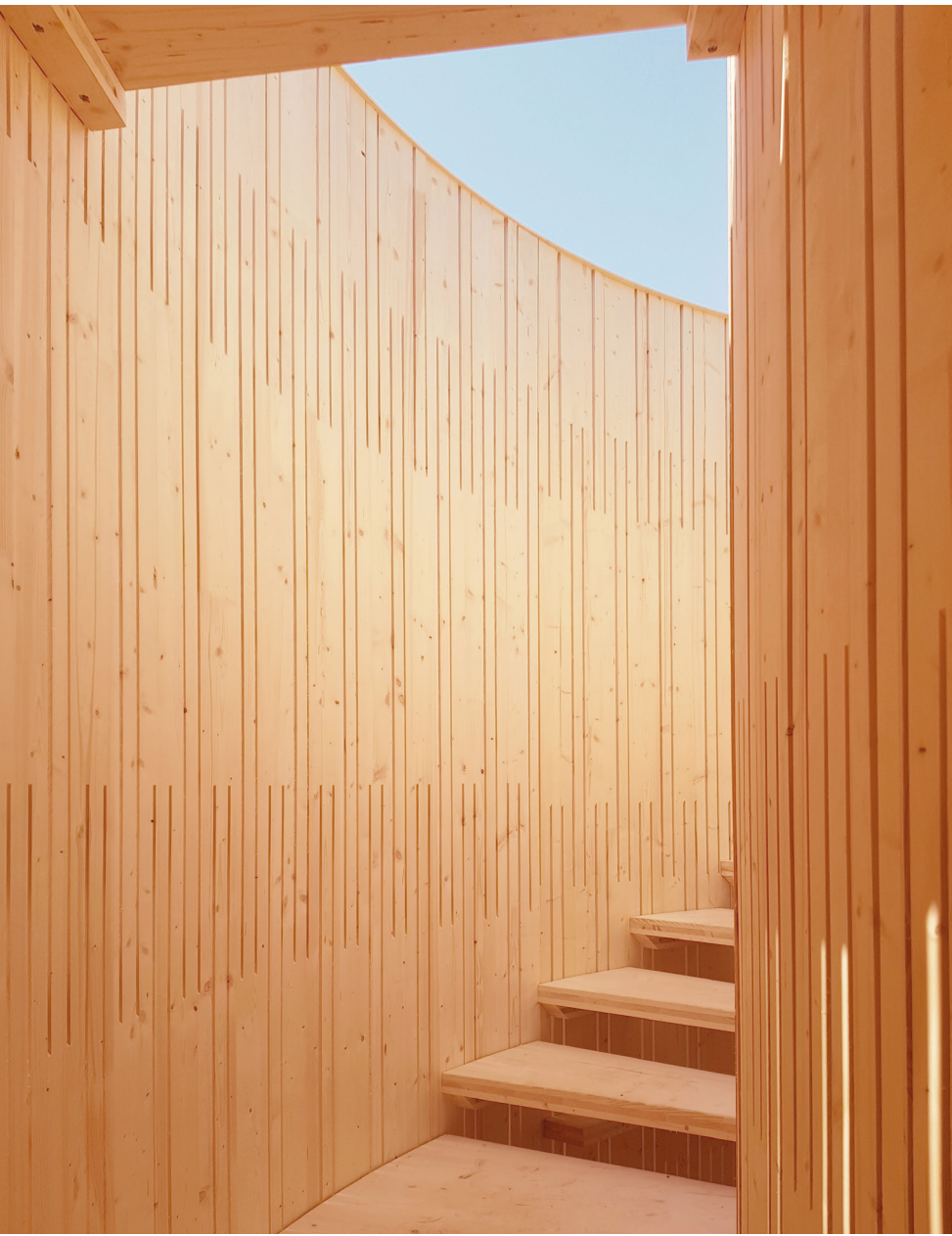
Les fentes, présentes à un rythme régulier, procurent sa souplesse au bois et lui permettent d'être courbé ©ArtBuild
