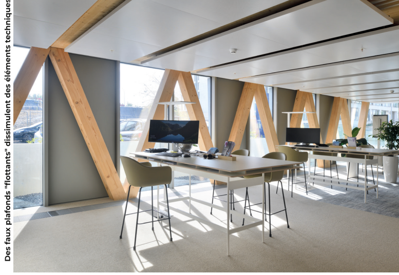
Des faux plafonds "flottants" dissimulant des éléments techniques
