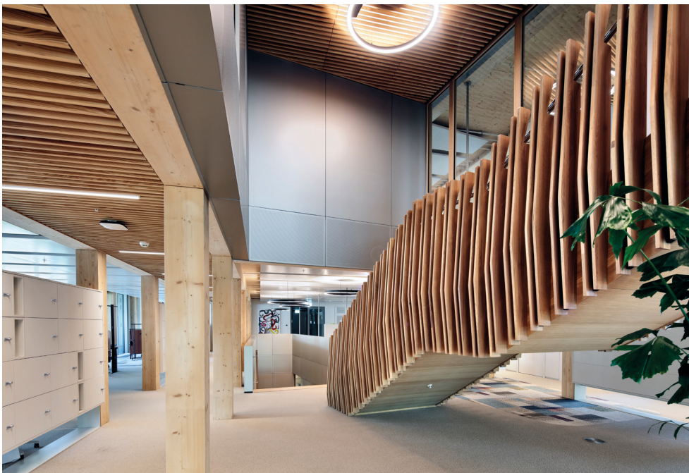
L'escalier monumental en construction bois ©Georges de Kinder
