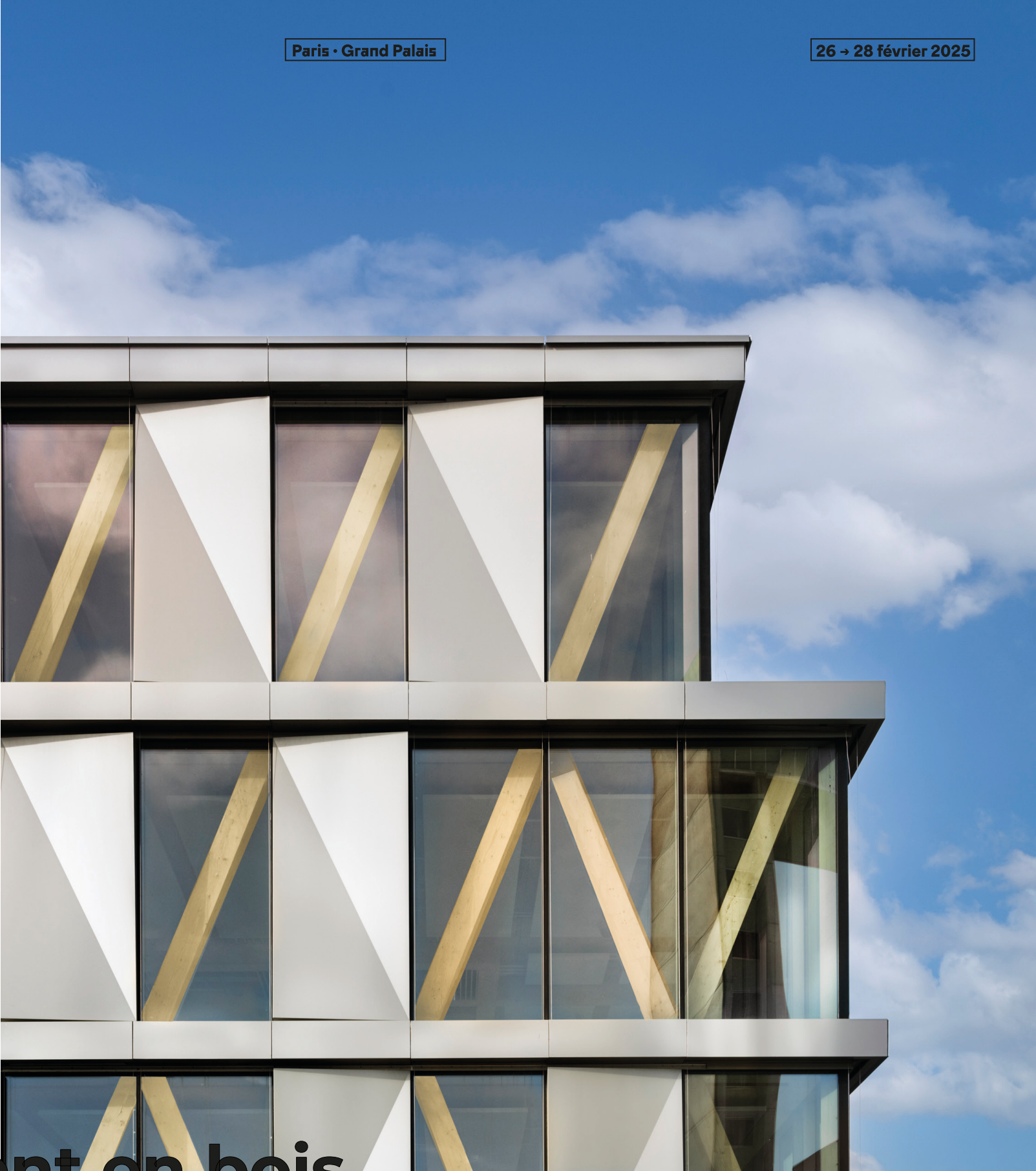
Des cassettes métalliques, dont les facettes s'accrochent au rythme de la structure bois
