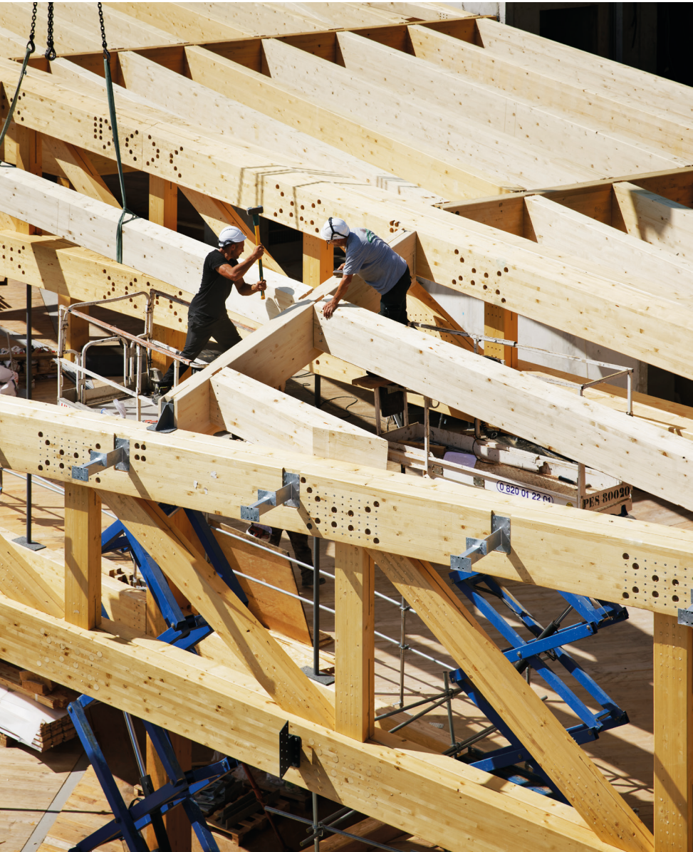
Le chantier du siège social de l'Office National des Forêts • 2021 • Photographie : ©Camille Charbi
