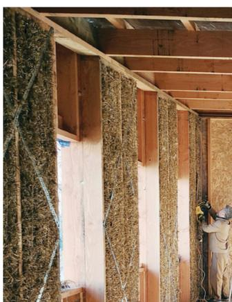
Remplissage des murs isolés en paille avec de la terre allégée • 2021 • ©Bellastock
