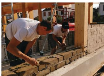
Maçonnerie du hourdis de blocs de terre comprimée • 2019 • ©Archipel Zero
