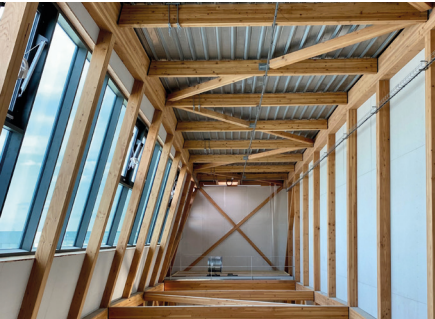
Charpente de la cheminée de la Valorization Unit • 2023 • ©BL-AU
