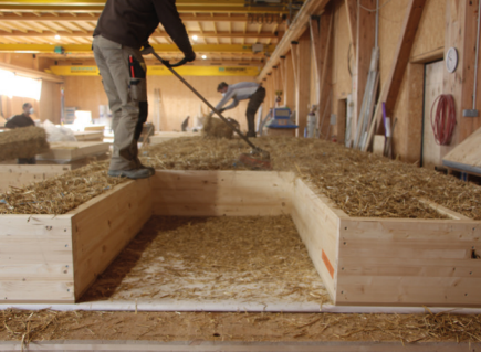
Mise en oeuvre des murs à ossature bois remplissage paille • 2022 • ©BL-AU
