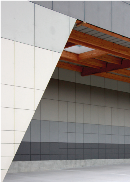
Façade de la Valorization Unit, panneaux Eternit de réemploi - Atelier des façadiers • 2023 • ©BL-AU
