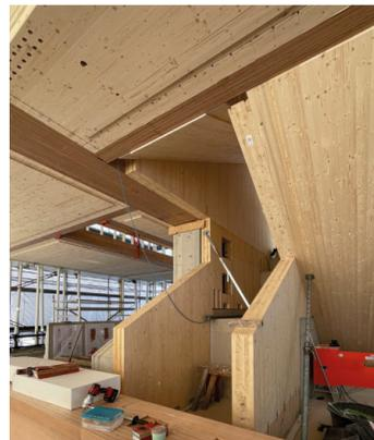
Tour des Archives du Bauhaus de l'architecte Staab Architekten. Escalier et planchers CLT, poutres en hêtre • 2020 • ©B+G
