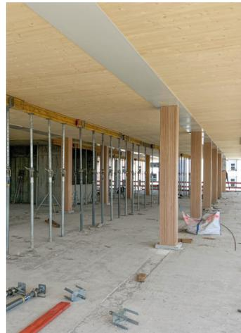
Poteaux Baubuche, poutres et planchers hybrides des bureaux "Dockyard" par l'architecte Tchoban Voss Architekten • 2023 • ©B+G
