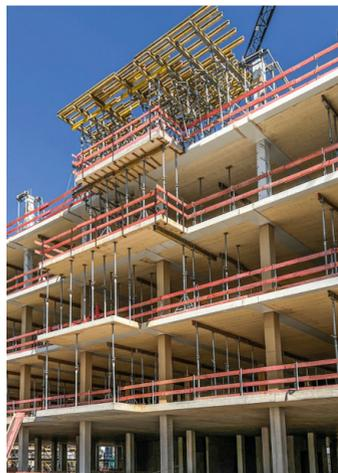
Montage de la structure à poutres et planchers hybrides des bureaux "Dockyard" par l'architecte Tchoban Voss Architekten • 2023 • ©B+G
