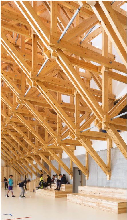
Portiques en bois massif posés sur le socle en béton 2023 • © Olivier Mathiotte
