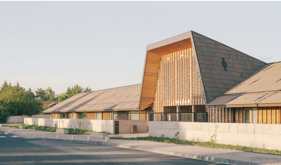
L'édifice s'inscrit dans la morphologie bâtie environnante, en empruntant le langage rural des noues, clôtures et matériaux 2024 • ©Charly Broyez
