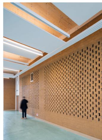
La terre crue prélevée sur le site a été utilisée pour les cloisons et parements de façade au rez-de-chaussée. ©Nicolas Waltefaugle
