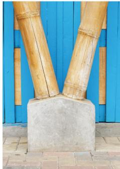
Détail de fondation de la structure en bambou • 2019 • ©DEMMAIN
