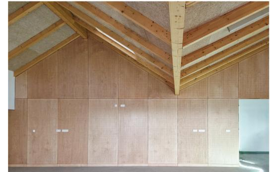
Les panneaux perforés et en fibre de bois des salles d'activités assurent un confort d'usage des espaces • 2024 • ©DEMMAIN
