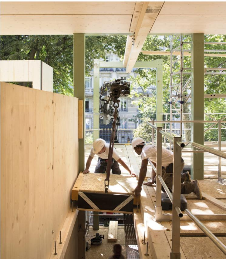
Les éléments de raccord réalisés en atelier sur mesure | 2019 | ©Clément Guillaume photographe
