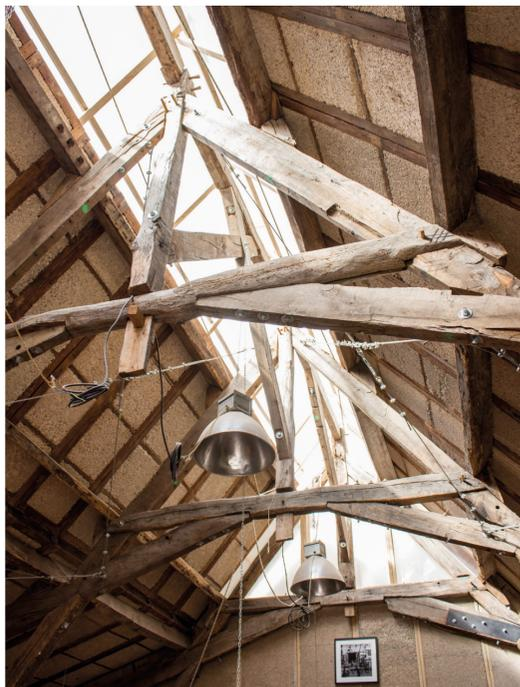
Charpente en chêne et panneaux de chanvre de réemploi ©A+1
