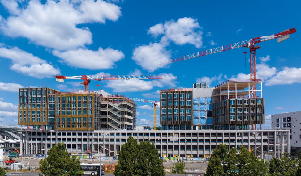
Chantier Le Carrousel • ©Gaël Arnaud
