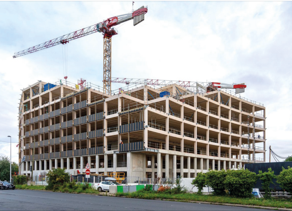
Chantier vue rue • ©Nicolas Thouvenin
