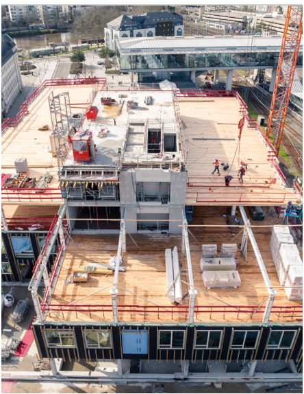
Vue aérienne du chantier • ©Gaël Arnaud
