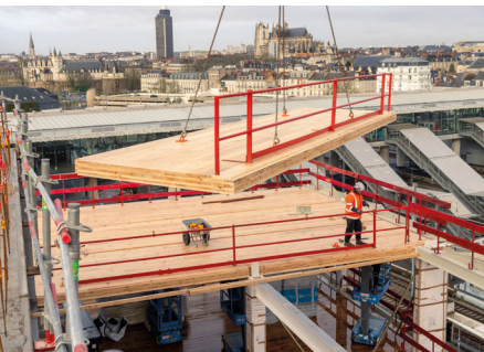
Pose des planchers CLT • ©Gaël Arnaud
