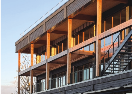
Photographie des façades en cours de chantier • 2025 • Photographie ©GBL
