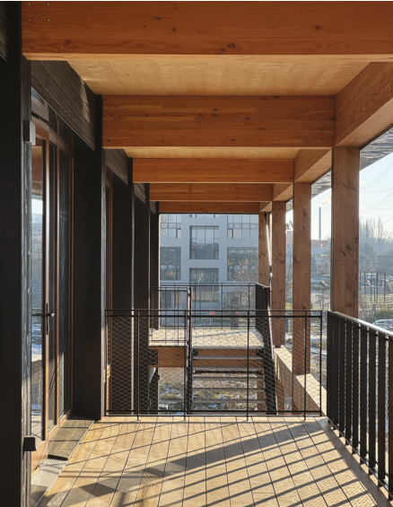
Loggias en cours de chantier • 2025 • Photographie ©GBL
