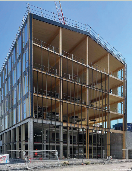
Photographie en cours de chantier montrant le système constructif • 2022 • Photographie : ©GBL
