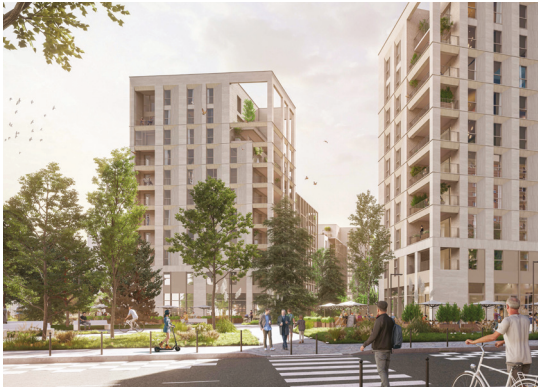
LILLE • VERRECCHIA • 168 logements • Façade en pierre porteuse • Balcons rapportés en structure bois ©Plug-in A.
