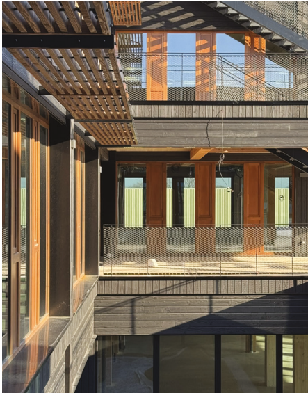
Façades en cours de chantier • 2025 • Photographie ©GBL
