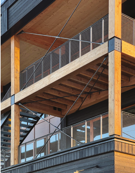
Façades en cours de chantier • 2025 • Photographie ©GBL
