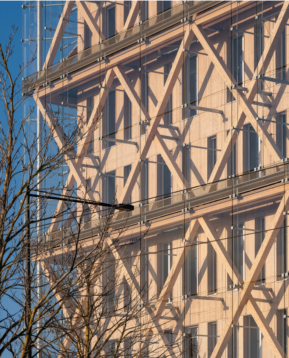
Façade principale - exostructure et double peau en verre • 2022 • ©Nicolas Waltefaugle
