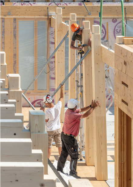
Montage des poteaux bois par les charpentiers • 2021 • ©Luc Boegly
