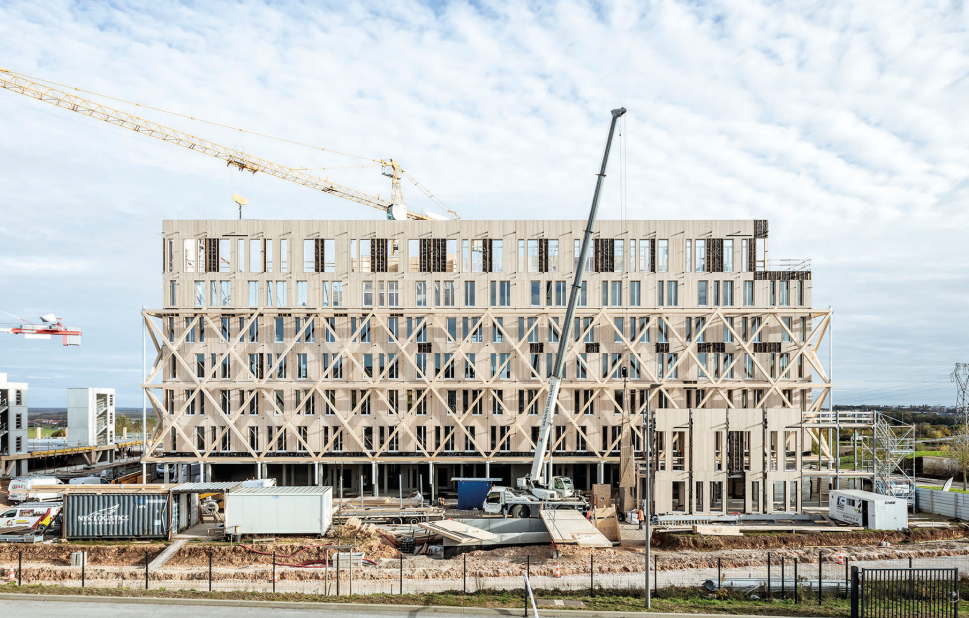
Image de la façade nord en phase de montage • 2021 • © Luc Boegly
