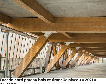
Facade nord poteau bois et tirant 3e niveau • 2021 • ©GRAAM
