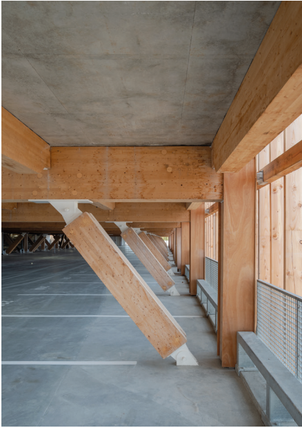
Poteau de façade 2e niveau • 2021 • ©Nicolas Waitefaugle
