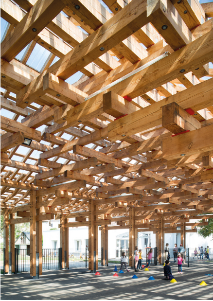
Charpente de la halle • 2017 • Photographe: Nicolas Waltefaugle
