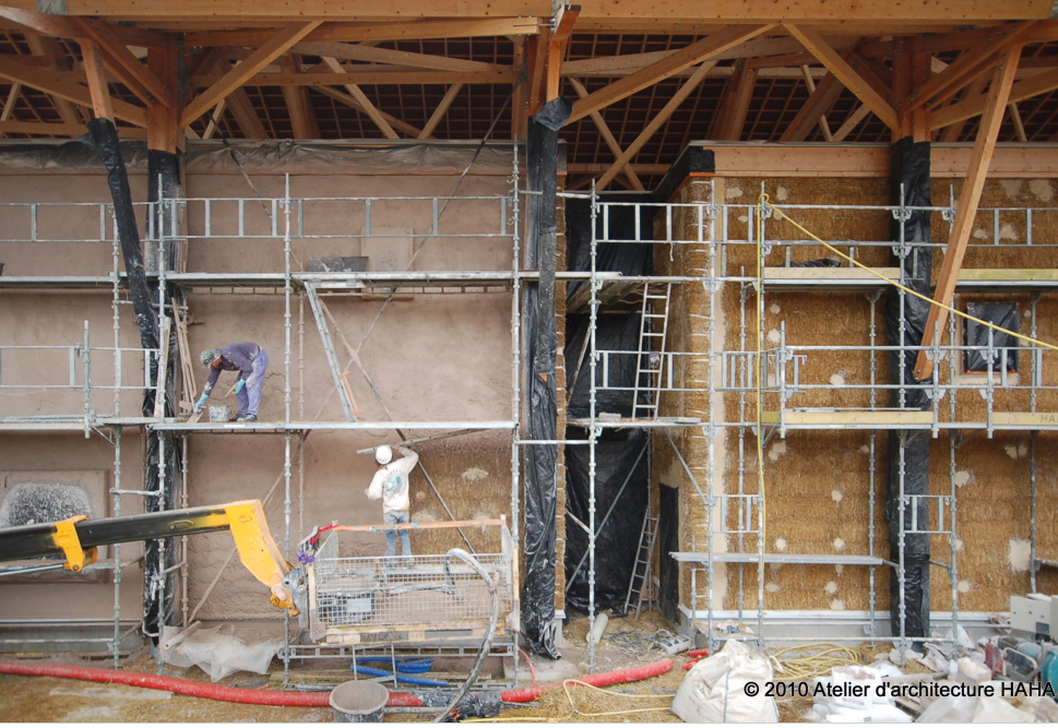
Isolation paille et enduit terre
