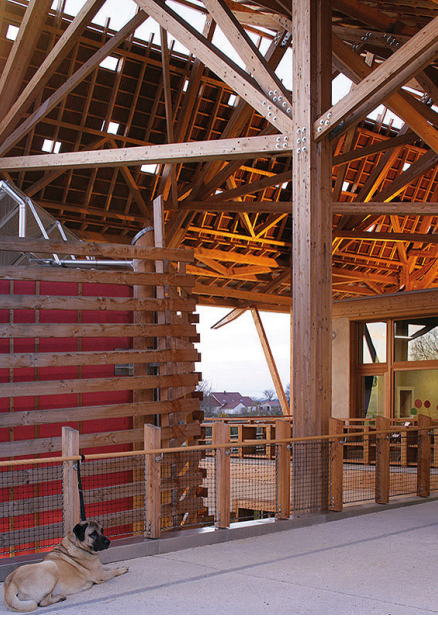
Vue du bâtiment depuis le seuil d'entrée
