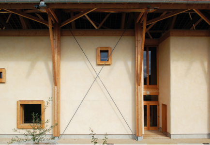
Mur terminé, enduit terre
