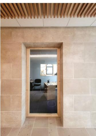
RDC, couloir central : mur de refend en pierre de Lanvignes, châssis fixe en pin local, vitrage de réemploi, sol en Comblanchien, 2024 • ©Julie Herrgott
