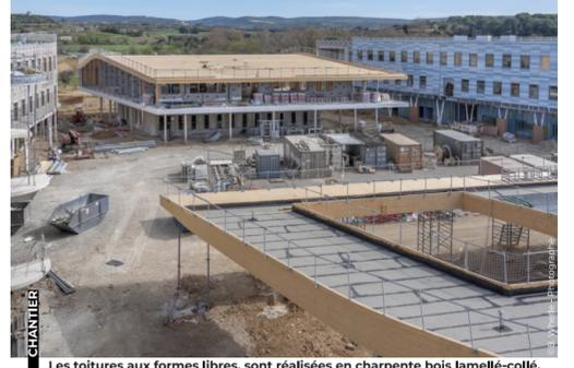
Les toitures aux formes libres, sont réalisées en charpente bois lamellé-collé, couverture bois + étanchéité et végétalisation
