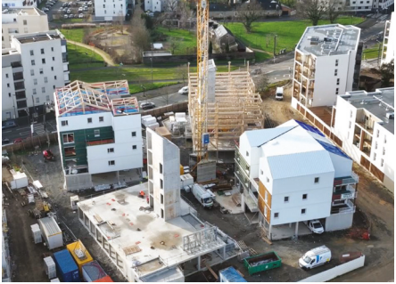
Photo de chantier ■ 2024 ■ ©LCA
