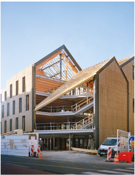
269 m³ de bois mis en œuvre pour la réalisation de la Station A ■ 2024 ■ ©Axel DAHL
