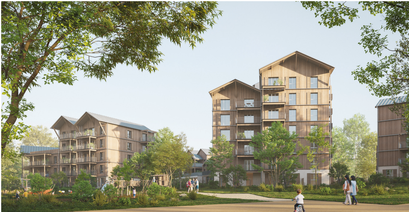
Construction de 65 logements intermédiaires et collectifs en accession sociale et libre à Saint-Nazaire (44) • Seuil 2025 de la RE 2020 - Matériaux biosourcés niveau 1 CISN • 2024 • ©Thomas PEPIN
