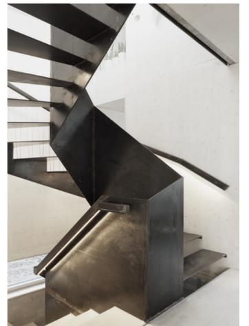
L'escalier a été réalisé à partir d'une seule pièce d'acier préfabriquée • 2015 • ©SchnepRenou
