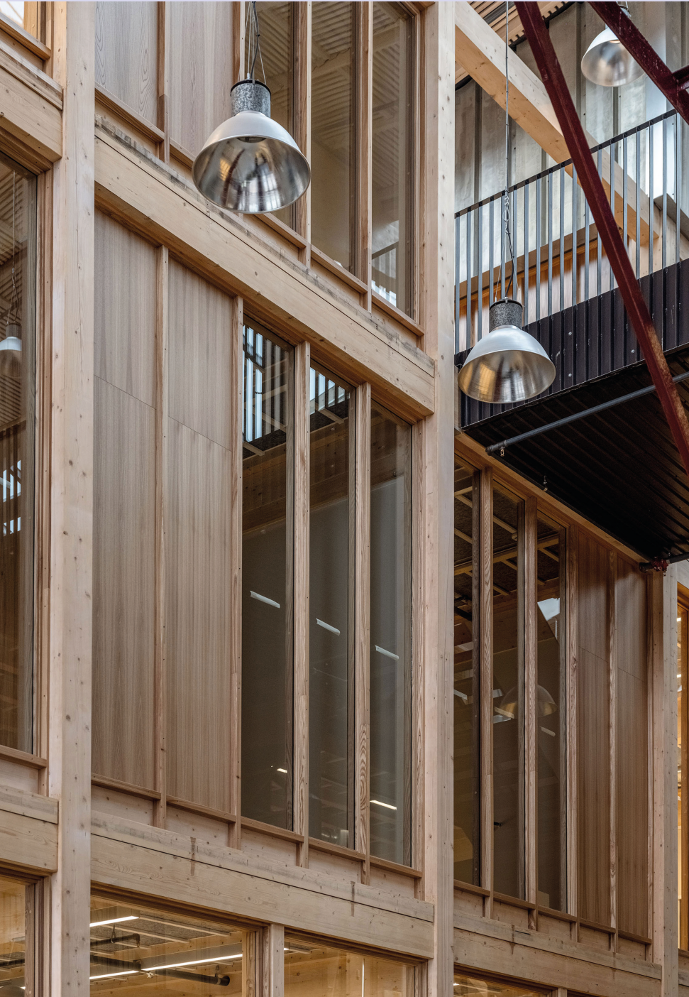
Détail intérieur cloisons en bois • 2023 • ©Rasmus Hjortshøj - COAST
