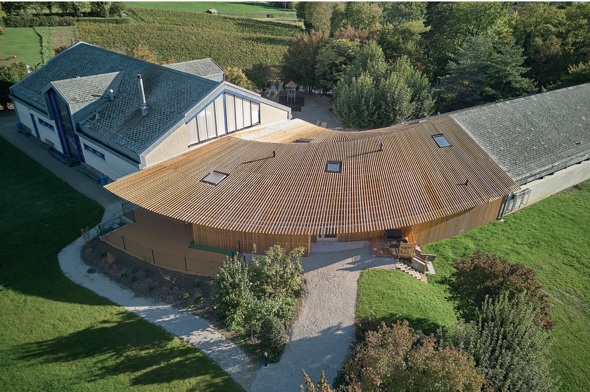
Toiture ondulée reliant les deux façades existantes • 2023 • ©Nicolas Delaroche
