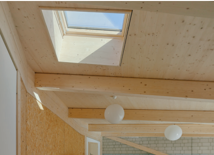
Ouverture zénithale dans la toiture • 2023 • ©Nicolas Delaroche
