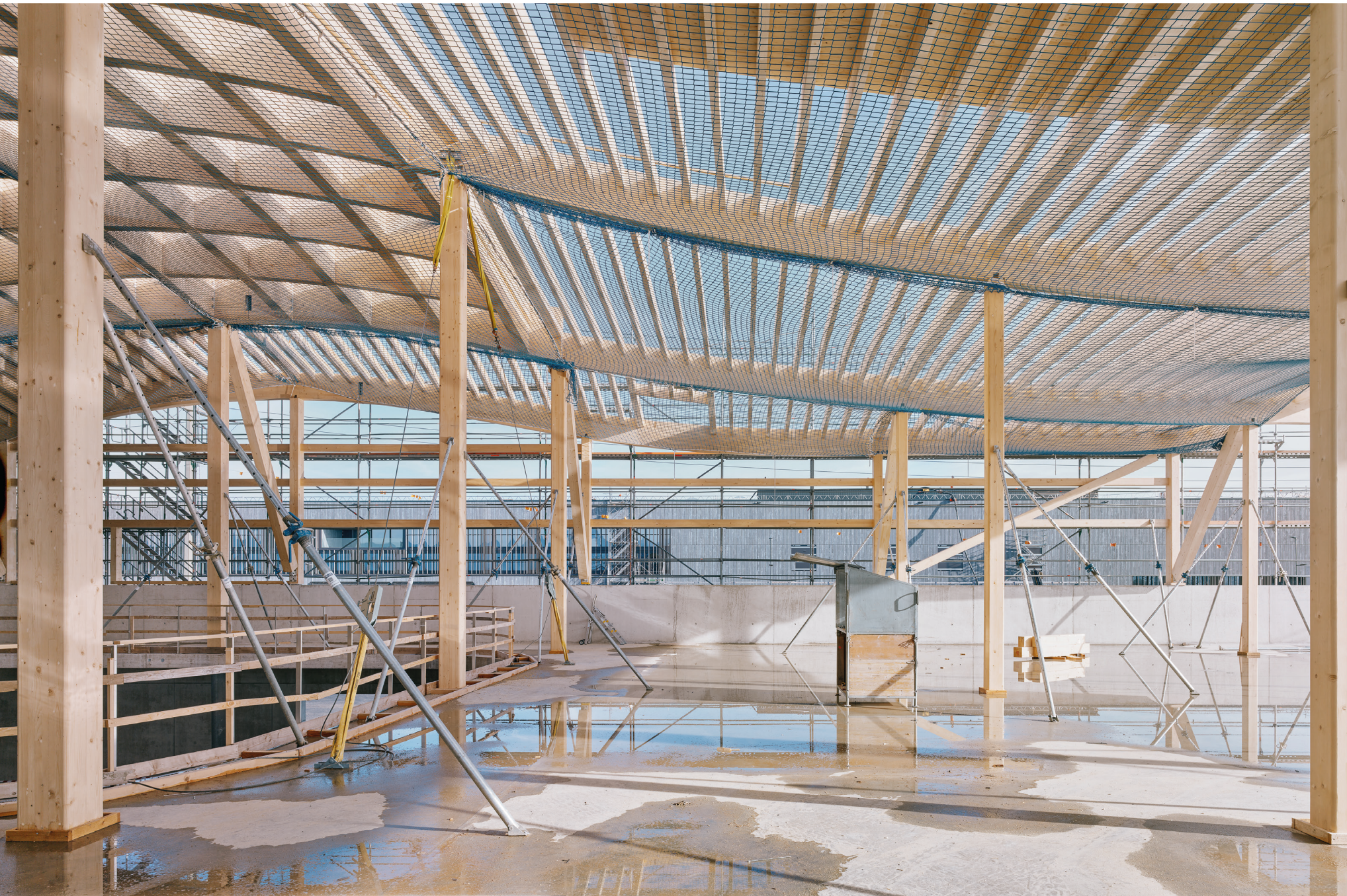
Charpente de toiture courbée en lamellé-collé • 2024 • ©Nicolas Delaroche
