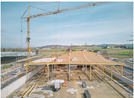
Ensemble de la charpente en lamellé-collé • 2024 • ©Nicolas Delaroche
