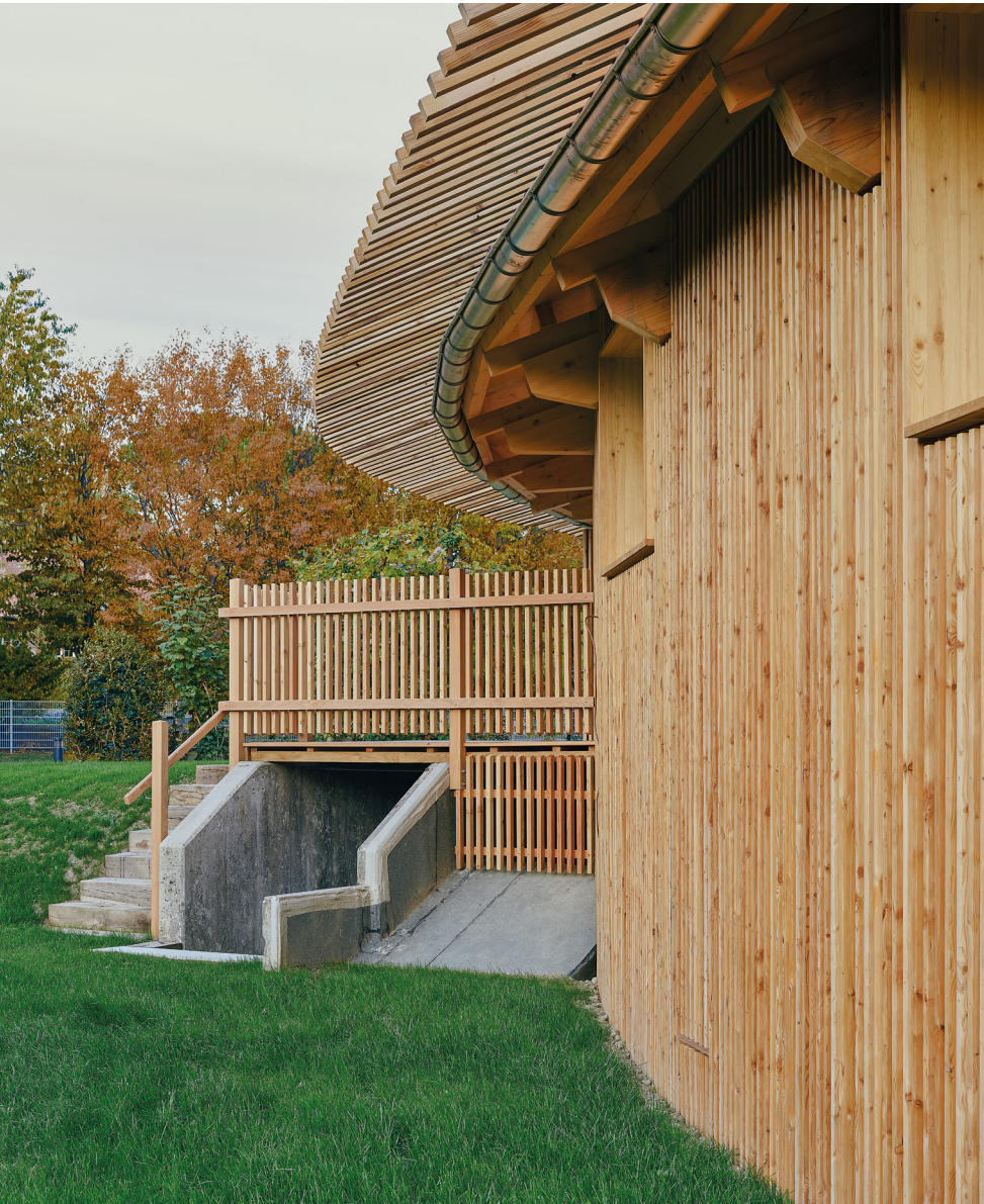
Façade arrière en bois de la crèche La Vufflantine • 2023 • ©Nicolas Delaroche
