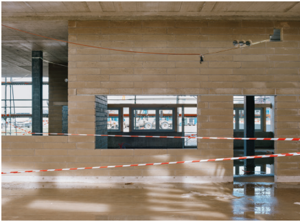
Mur en briques de terre compressée au rez-de-chaussée • 2024 • ©Nicolas Delaroche
