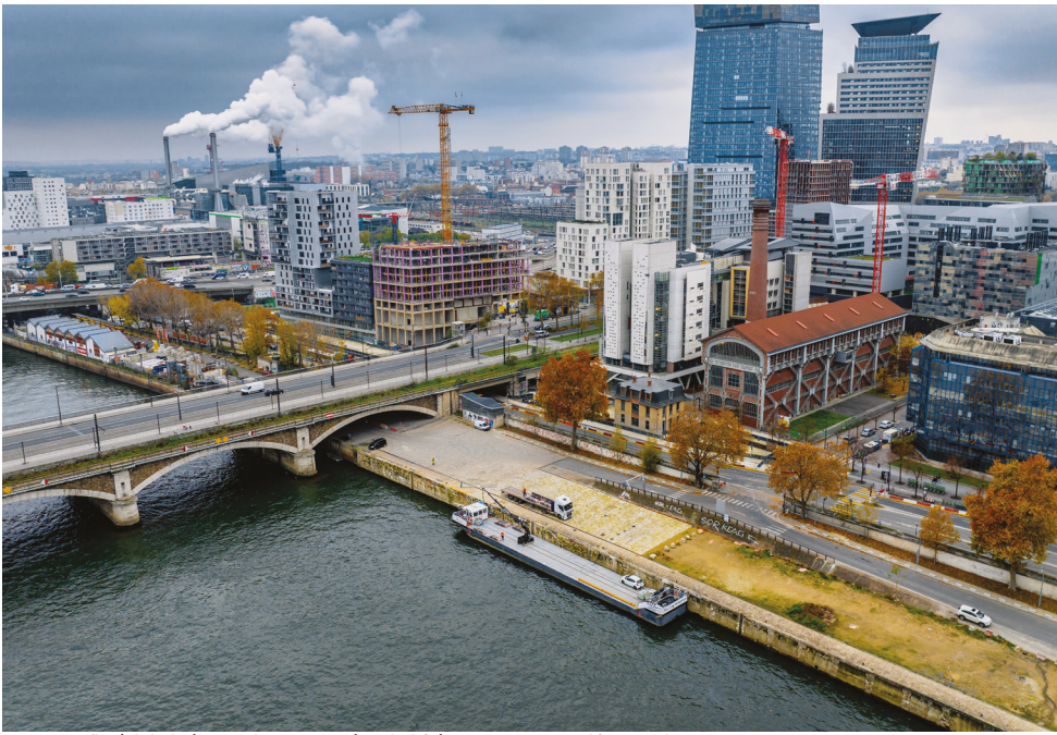
Transport fluvial du bois pour la construction du bâtiment • 2023 • ©Clément Chauvet
