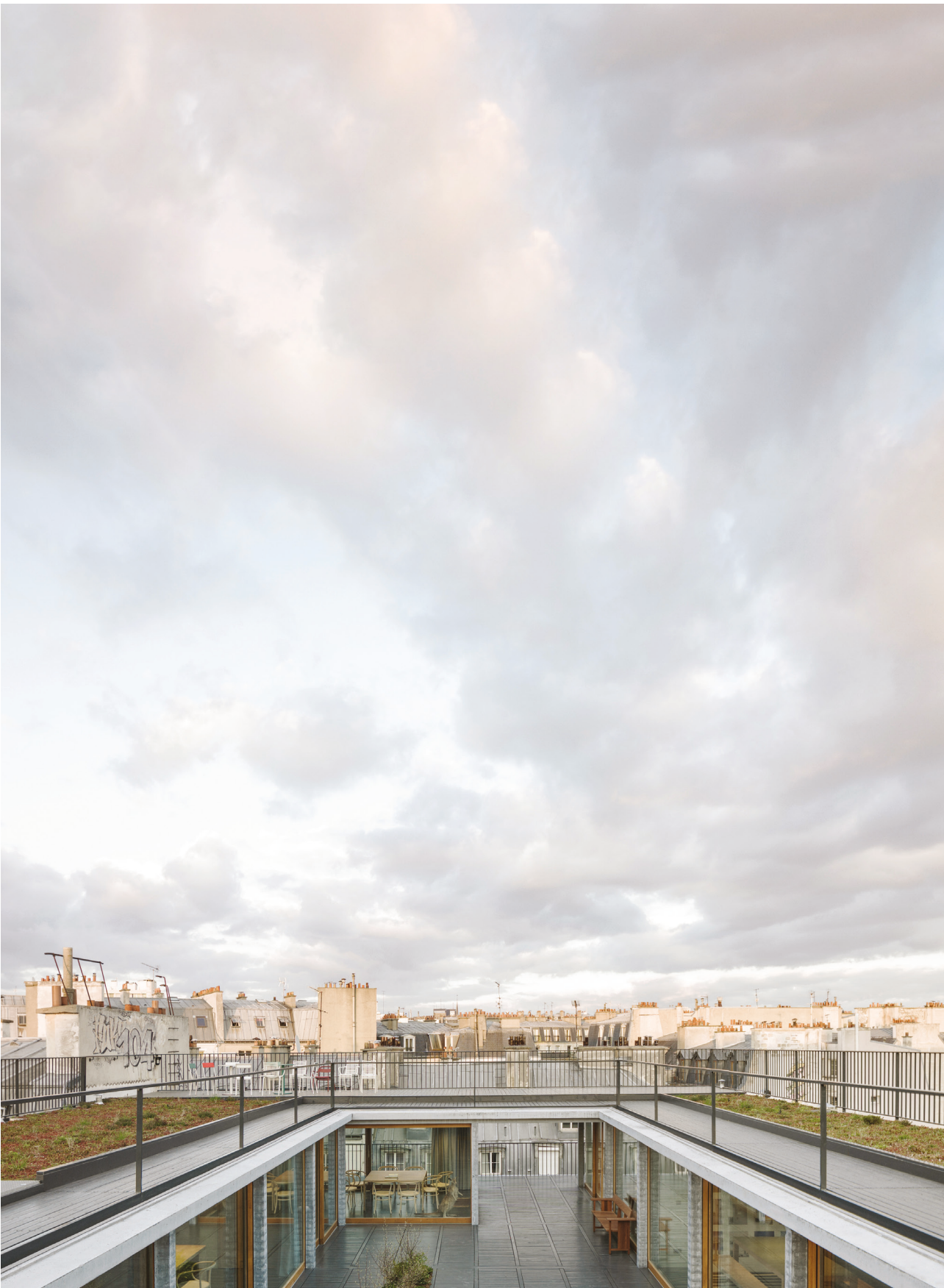
L'atelier du 47 rue Popincourt : la terrasse du dernier étage • 2019 • Photographie : ©Cyrille Weiner
