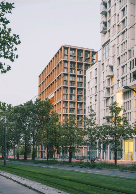
La tour Wood Up depuis le boulevard • 2024 • ©Charly Broyez
