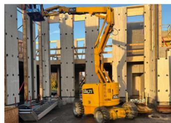
Mise en oeuvre des panneaux préfabriqués • 2024 •
