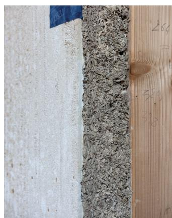
Composition du panneau en béton de chanvre préfabriqué • 2024 •
