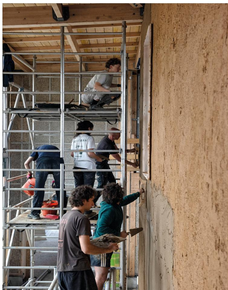
Pose des enduits terre sur le mur terre/paille/chanvre, chantier apprenant • 2024 •
