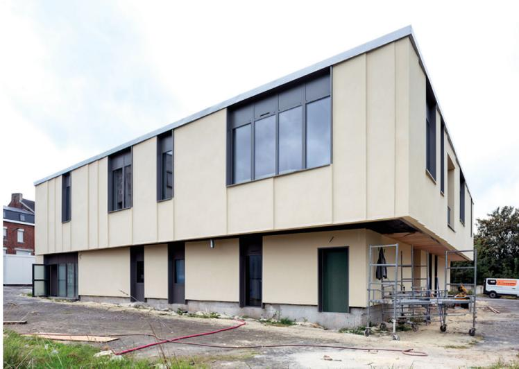
Facade panneaux béton de chanvre préfabriqué/enduit chaux • 2024 • ©Laps Architecture/Alia Bengana/David Cousin Marsy
