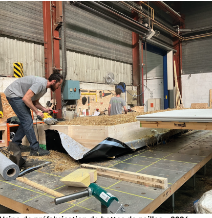
Usine de préfabrication de bottes de pailles • 2024 • ©Lipsky Rollet Architectes
