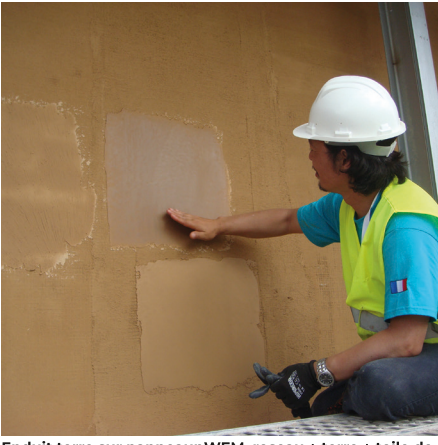
Enduit terre sur panneauWEM, roseau + terre + toile de jute • 2024 • ©Pascal Rollet
