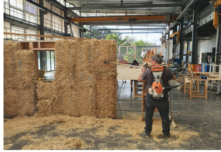
Formation paille aux grands ateliers • 2024 • ©Lipsky Rollet Architectes
