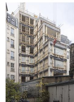
Assemblage de la façade à ossature bois sur cours • 2024 • ©CyrilleLallement
