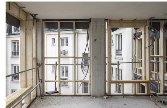
Assemblage de la façade à ossature bois sur cour • 2024 • ©CyrilleLallement
