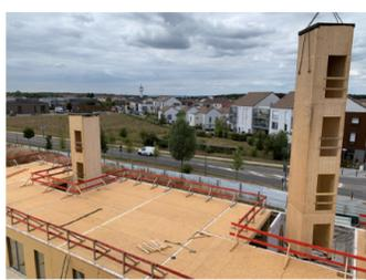
Mise en place des gaines ascenseur en CLT • 2021 • ©M'CUB architectes
