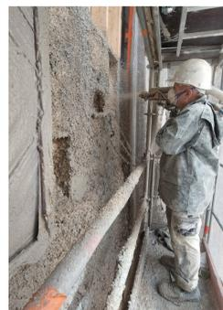
Projection du béton de chanvre • 2023 • ©LM Ingénieur
