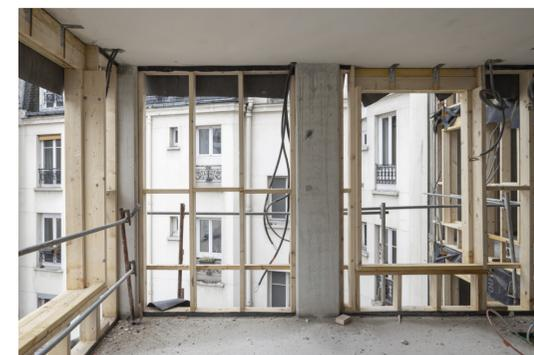
Assemblage de la façade à ossature bois sur cour • 2024 • ©CyrilleLallement
