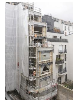
Projection de béton de chanvre dans le FOB • 2024 • ©CyrilleLallement
