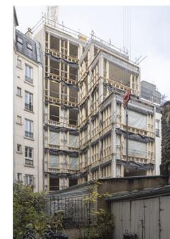
Assemblage de la façade à ossature bois sur cours • 2024 • ©CyrilleLallement
