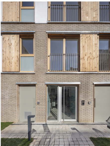
Entrée depuis la rue ■ Socle du bâtiment en briques pleines, assurant son ancrage au sol ■ 2021 ■ ©CécileSeptet
