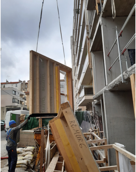
Pose des FOB ■ 2021 ■ ©NXNW
