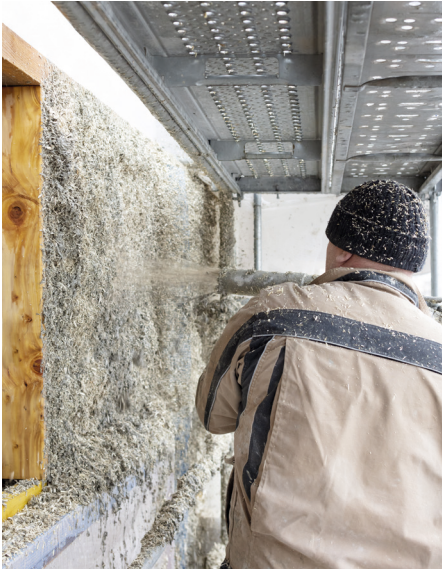
Projection du mélange chaux-chanvre ■ 2021 ■ ©CécileSeptet
