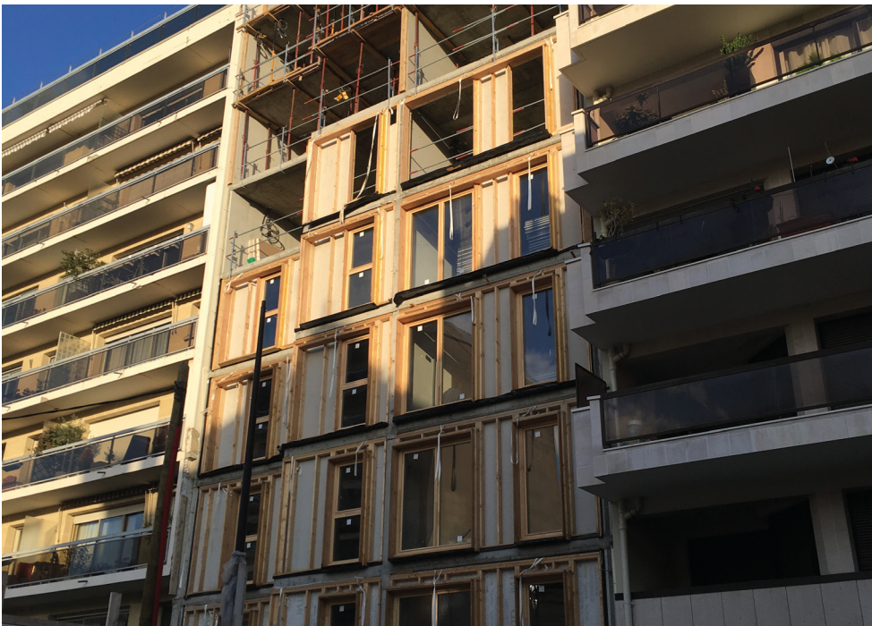
FOB posées sur la structure primaire ■ 2021 ■ ©NXNW
