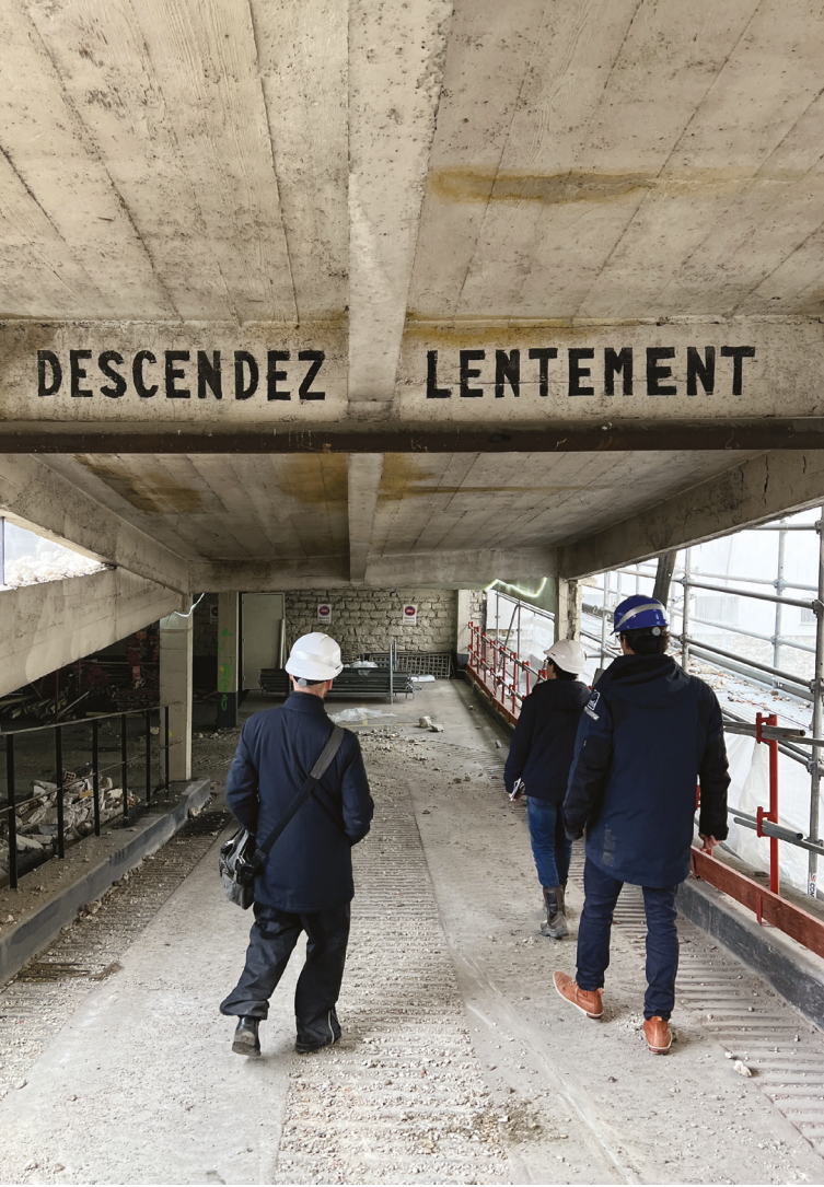
Vue du parking avant démolition
