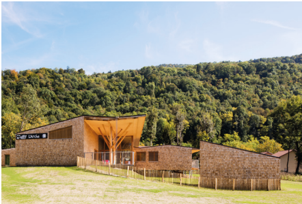
La toiture multipente constitue un pil dont la dynamique fait écho au soulèvement du bâtiment et à l'arborescence de ses porteurs • 2017 • ©Jussi Taimen
