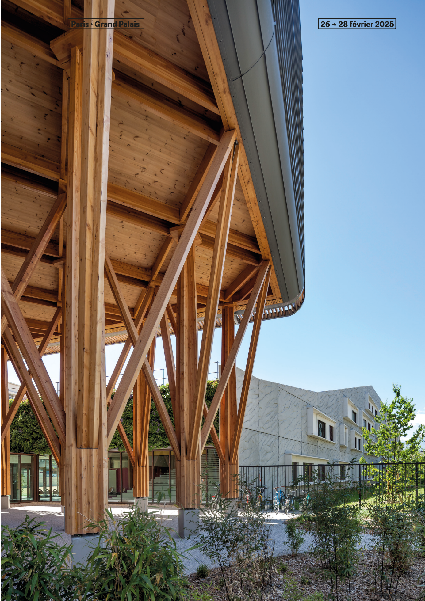
Préau du Lycée des Eaux Claires, Grenoble (38) • 2013 • Photographie : ©Bruno Romain
