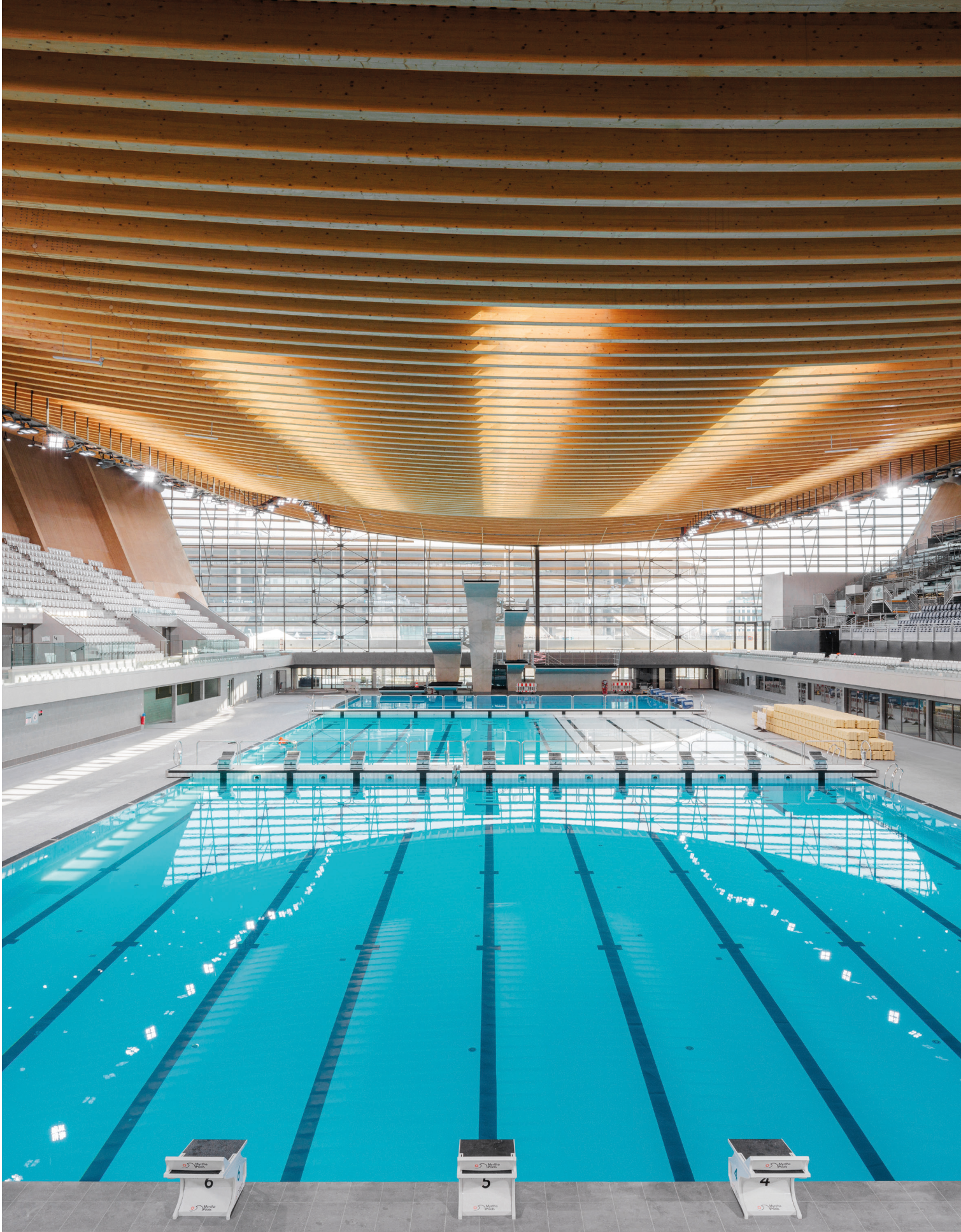
Vue de la halle olympique avec son bassin modulable dominant par transparence sur le Stade de France • 2024 • ©Salem Mostefaoui
