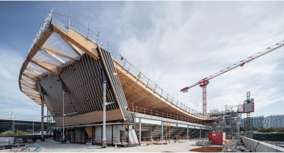
Vue de l'angle sud-est de la charpente, depuis le parvis est Phase chantier • 2022 • ©Salem Mostefaoui
