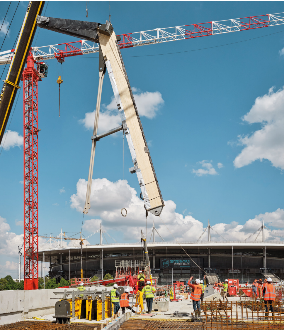
Pose du premier poteau tirant - Phase chantier • 2022 • ©Jean-Philippe Mesguen
