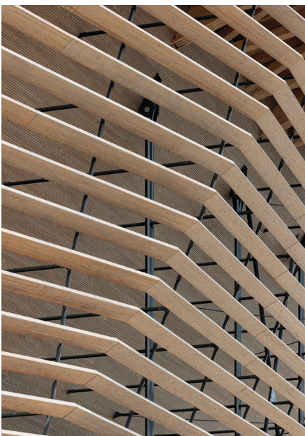
Détail de façade : brise-soleil en douglas PEFC pré-grisé ■ 2024 ■ ©Salem Mostefaoui
