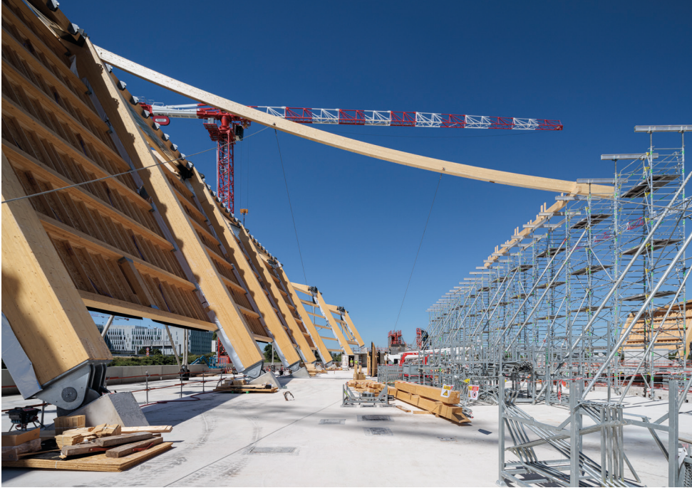
Pose de la première catène - Phase chantier • 2022 • ©Salem Mostefaoui
