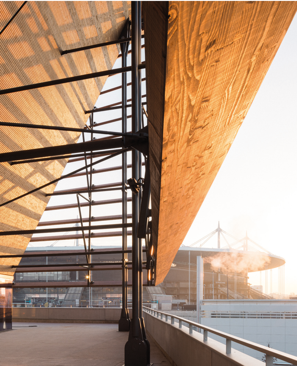
Terrasse sud avec perspective sur le Stade de France • 2024 • Photographie : ©Salem Mostefaoui
