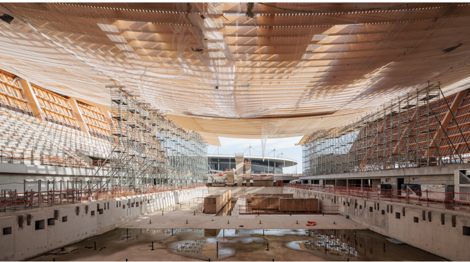
Vue de la halle olympique - Phase chantier • 2022 • ©Salem Mostefaoui
