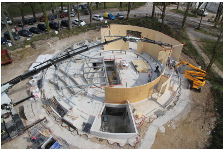
Vue du montage CLT • 2024 • ©Studio Andrew Todd
