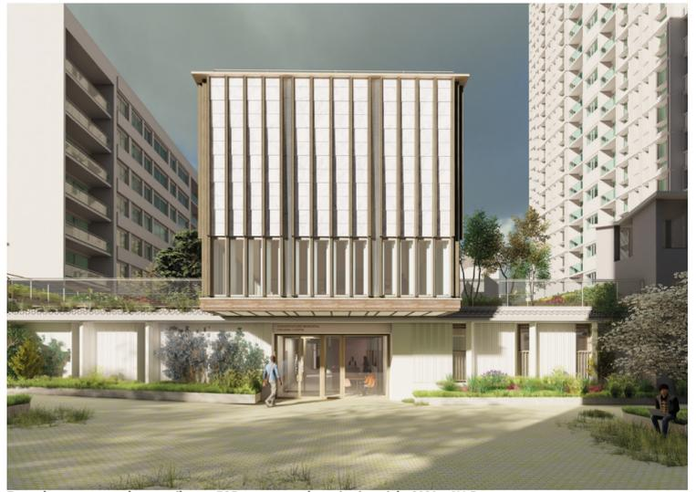
Extension structure acier, remplissage FOB, parement pierre de réemploi • 2020 • ©V. Doray
