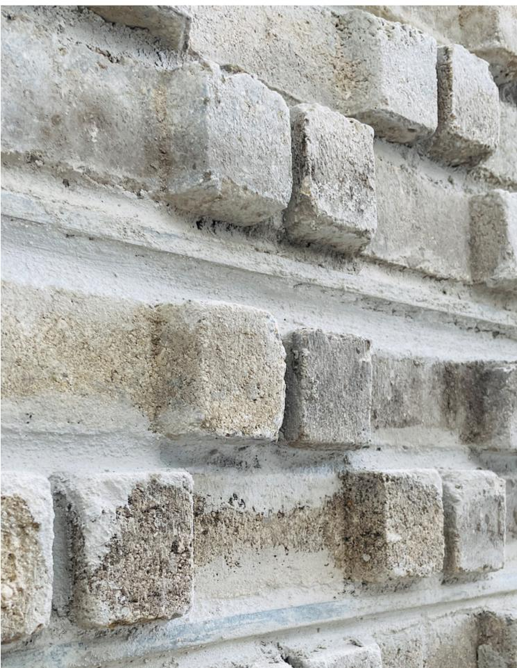
Les poutres métalliques s'intègrent au calepinage du double mur.
