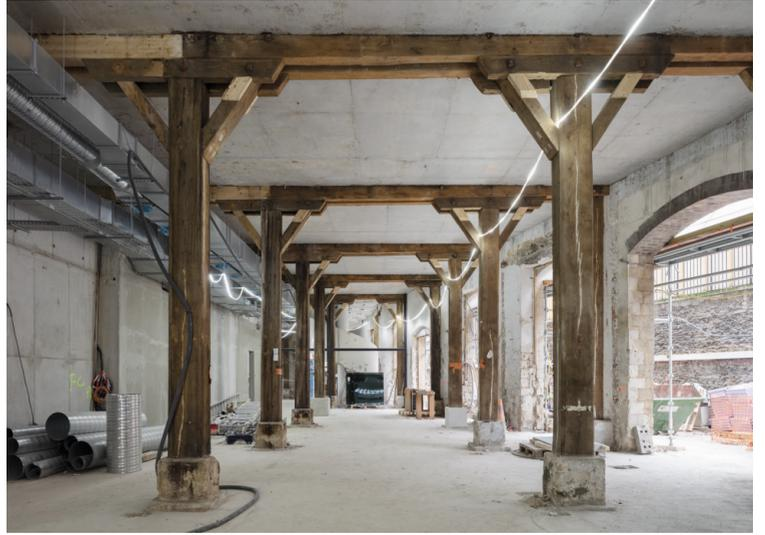
Chantier : la structure poteau poutre bois existante en cours de renforcement. • 2022 • ©Schneppe Renou
